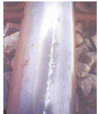
Gambar 15. Goresan pada kepala rel ( dokumentasi PT. KA )
