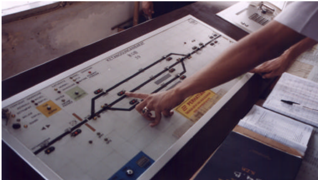
Gambar 5. Meja Pelayanan yang ada di Ruang PPKA Ketanggungan Barat
