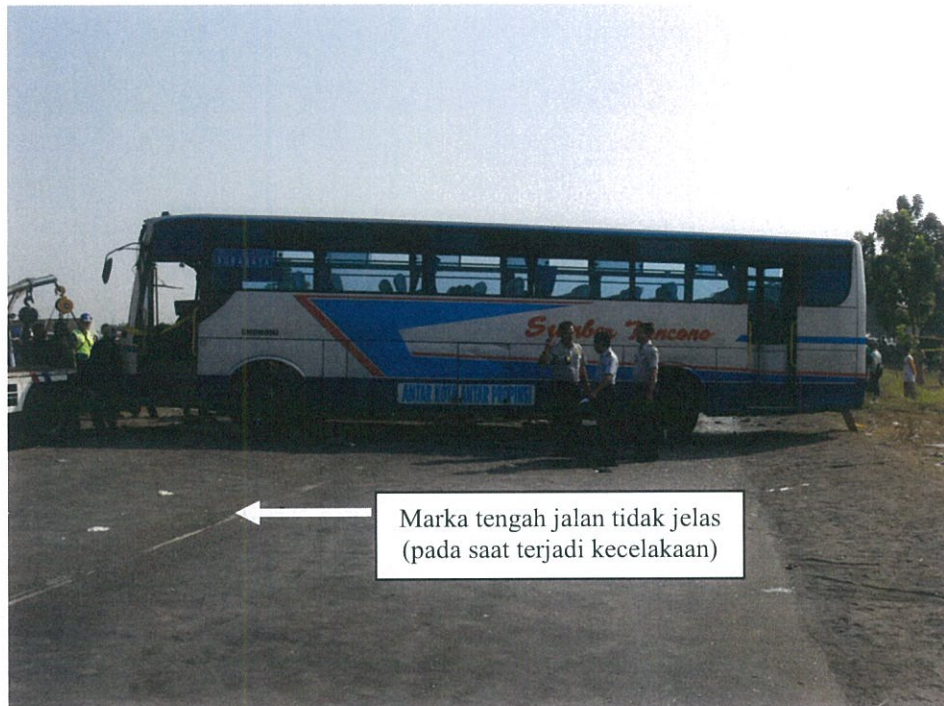
Gambar 1. Marka tengah jalan tidak jelas
