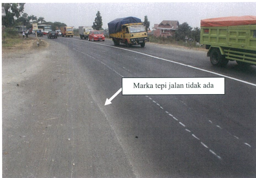
Gambar 2. Marka tepi jalan dan lampu penerangan jalan umum tidak ada
